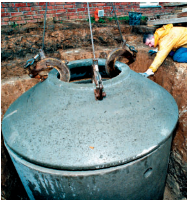
Einbau einer Zisterne ins Erdreich mit Kran Foto: Olaf Heil
