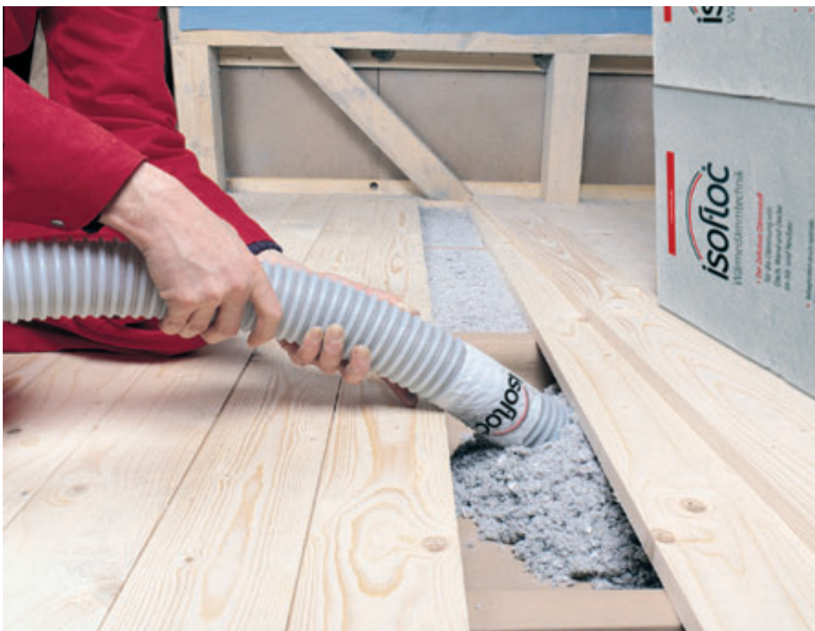
Nachträgliches Einblasen von Isofloc in Hohlräume
